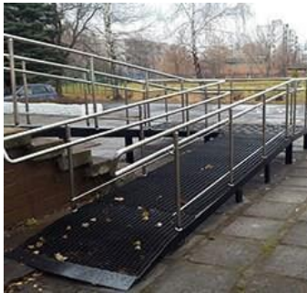
Стационарный пандус Идеал с настилом из просечно-вытяжного листа, поручнями из нержавеющей стали
